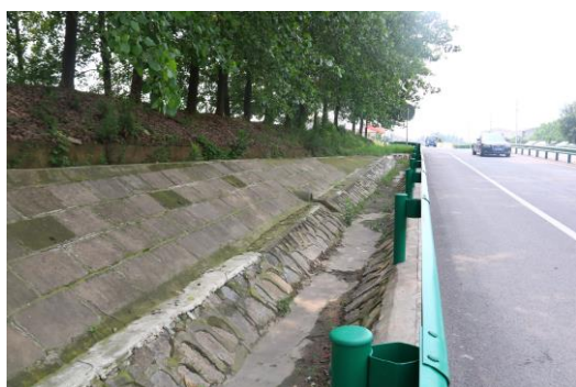
深挖边坡预制块排水沟
