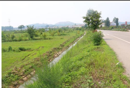
一般填方路基混凝土排水沟
