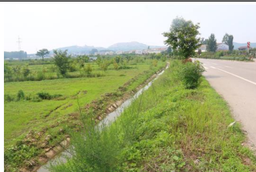
一般填方路基混凝土排水沟
