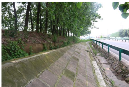
深挖边坡上部植被、下部预制块防护
