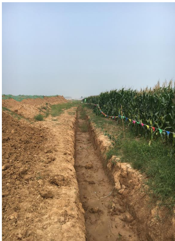
照片 2.16 路基工程区临时排水沟
