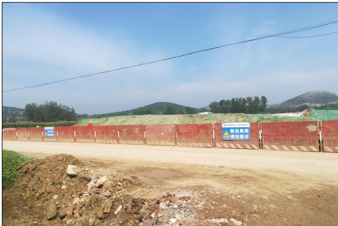
照片 2.14 路基工程区临时堆土拦挡及密目网覆盖
