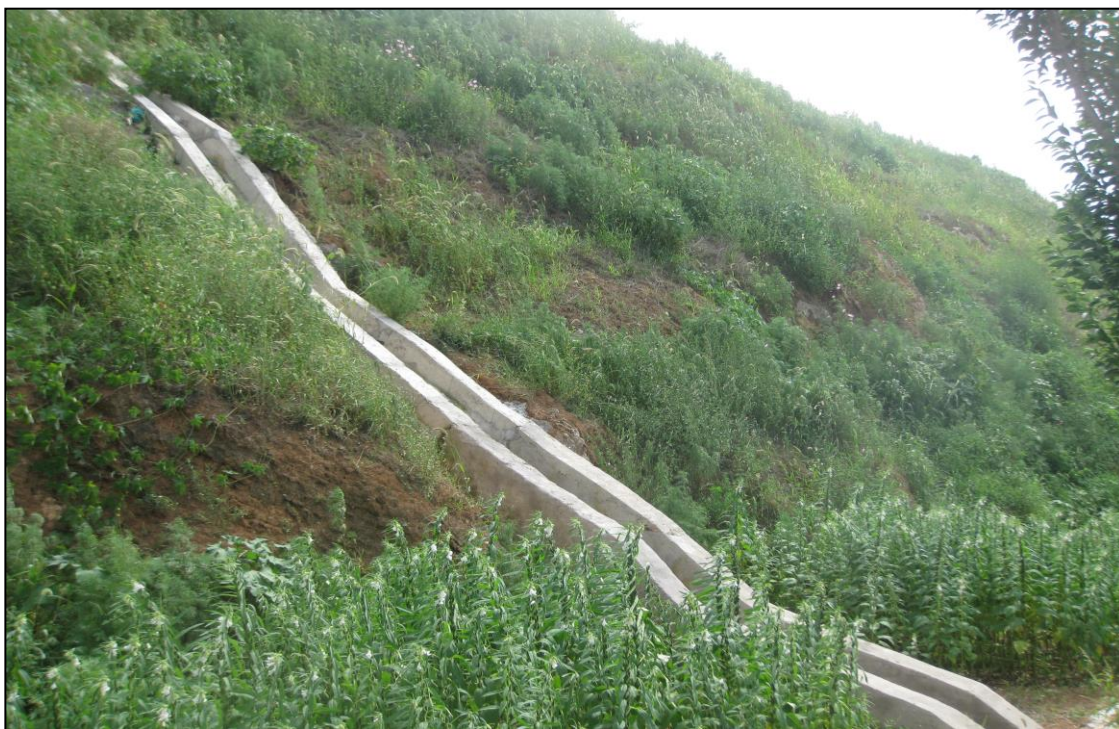
照片 2.3 路基工程纵向排水沟
