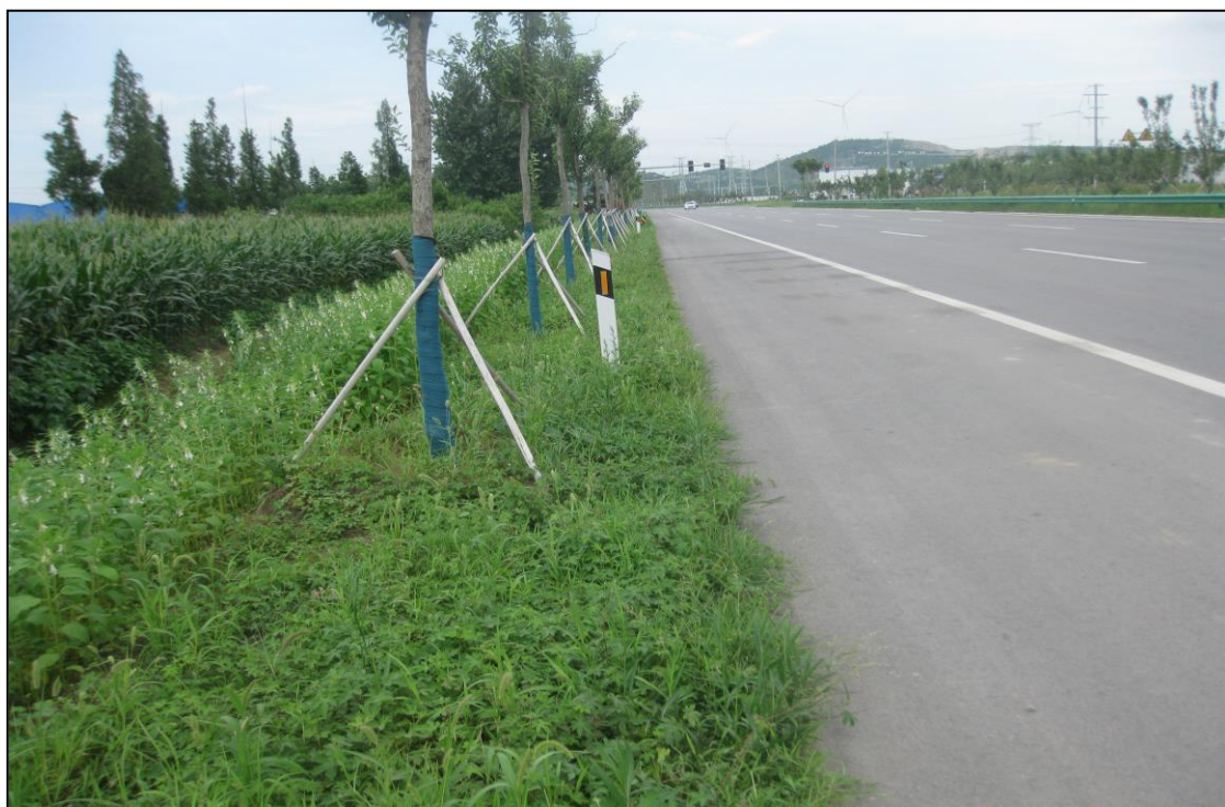
照片 2.11 路基工程边坡绿化
