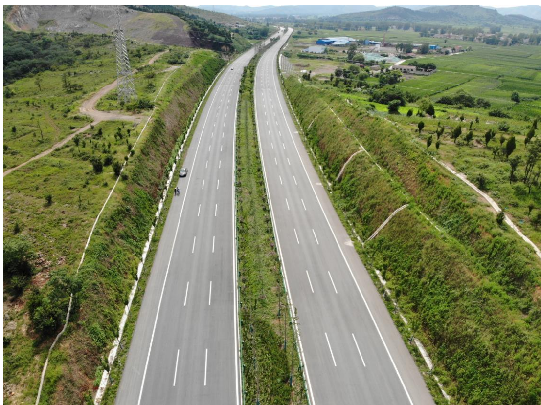
照片 2.8 厚层基材植草护坡
