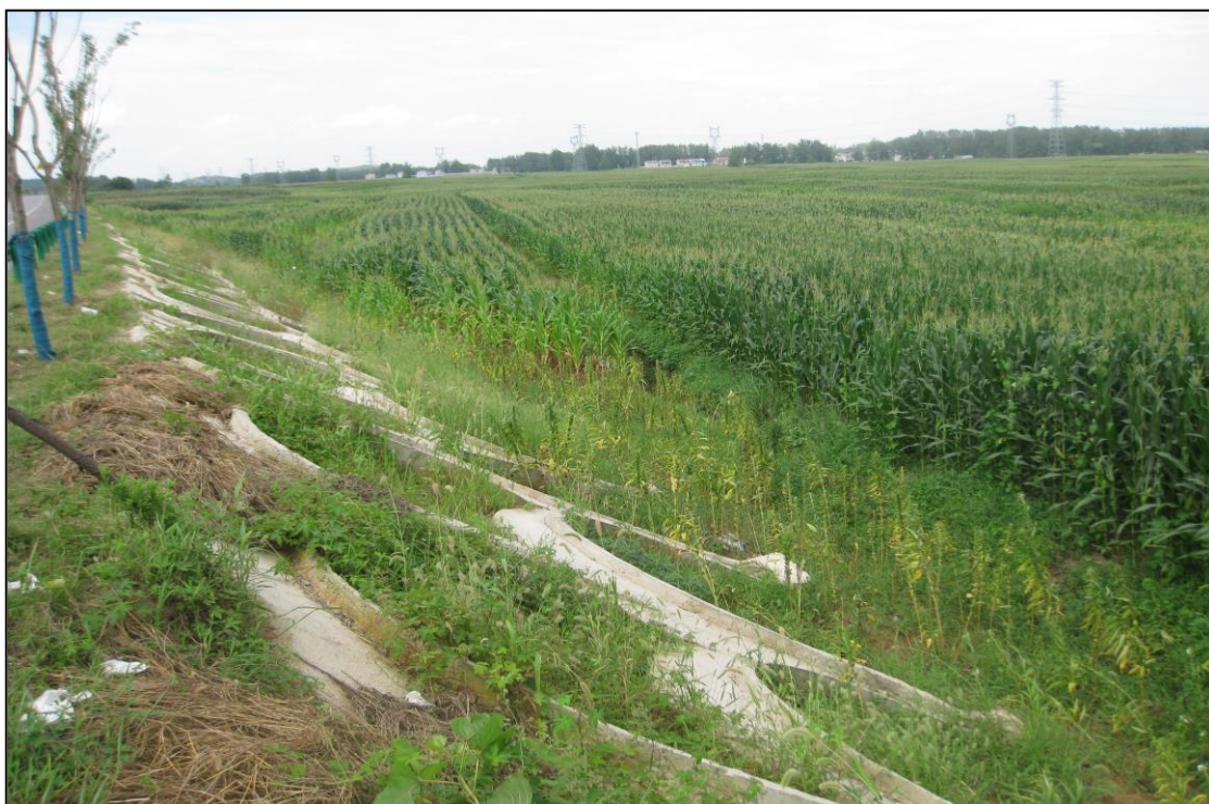
照片 2.6 路基工程拱形骨架护坡
