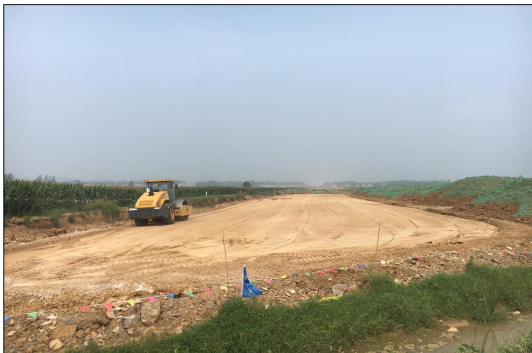
照片 2.18 路基工程区临时堆土密目网覆盖
