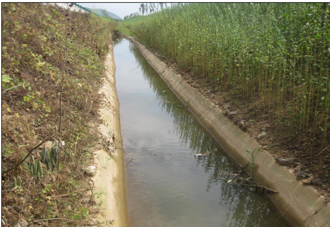
照片 2.4 分离式路基浆砌石排水沟
