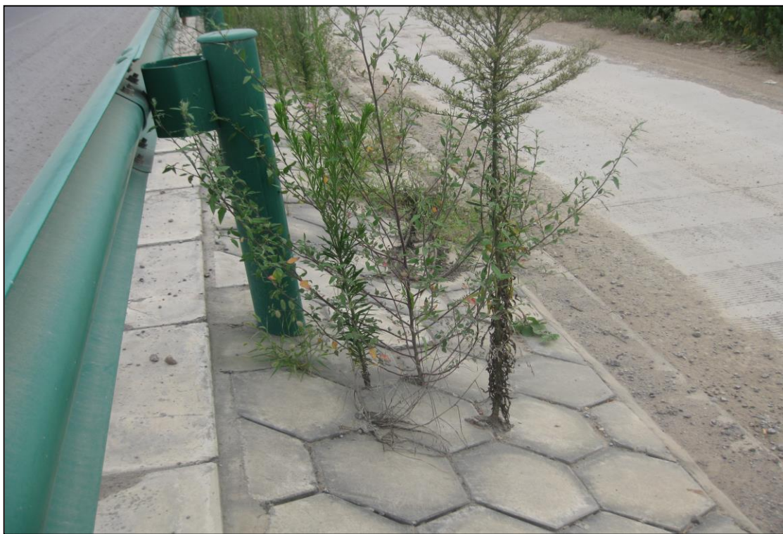
照片 2.7 路基工程浆砌护坡
