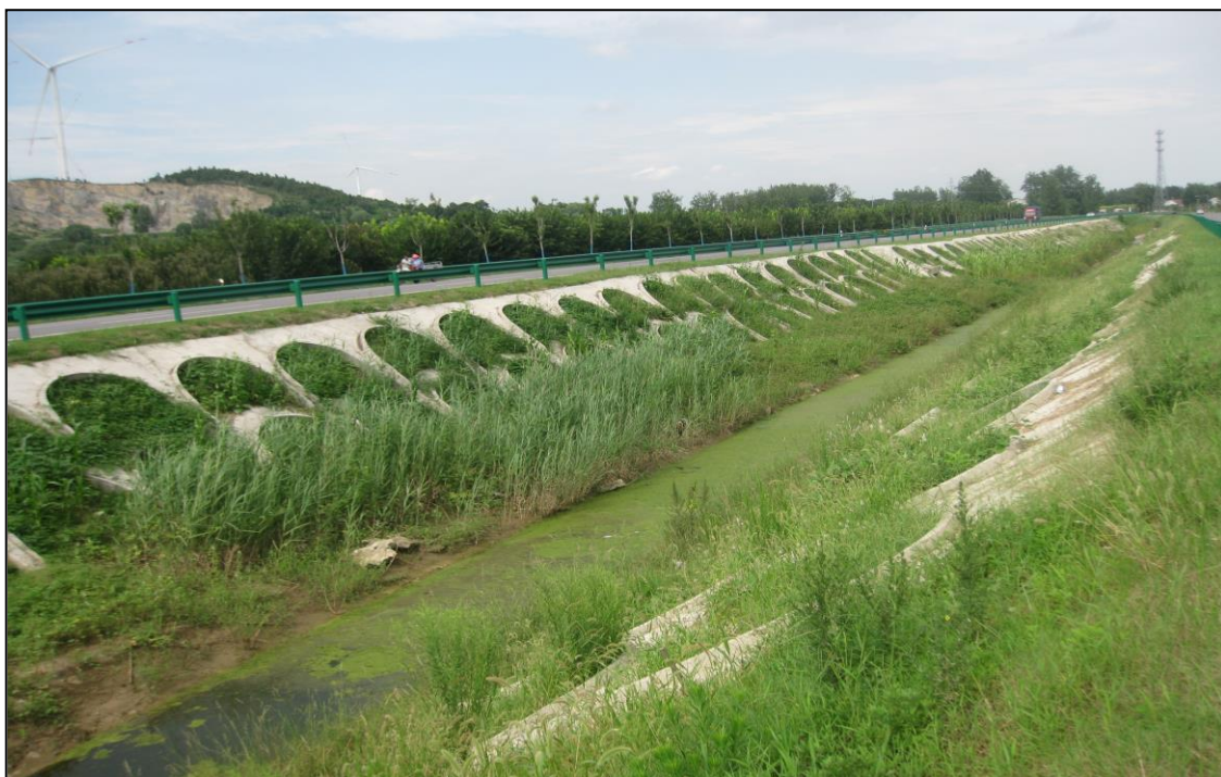
照片 2.5 分离式路基拱形骨架护坡
