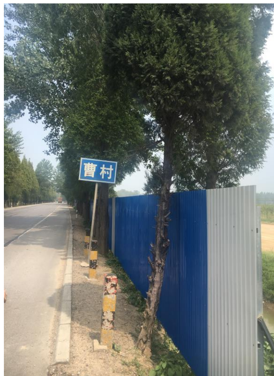
照片 2.17 分离式路基施工彩钢板拦挡
