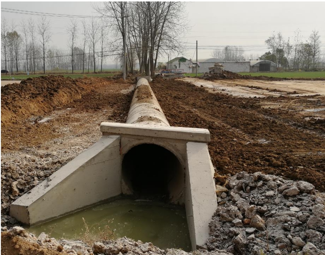
照片 1.3 过路涵洞工程施工
