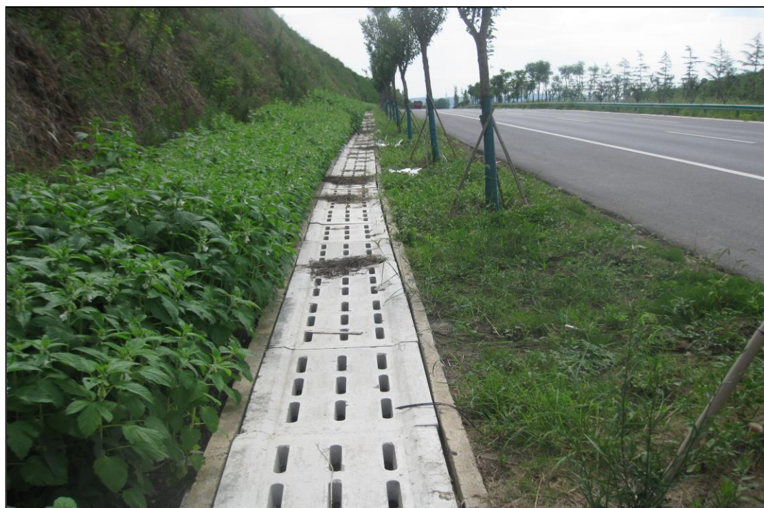
照片 2.2 路基工程盖板排水沟
