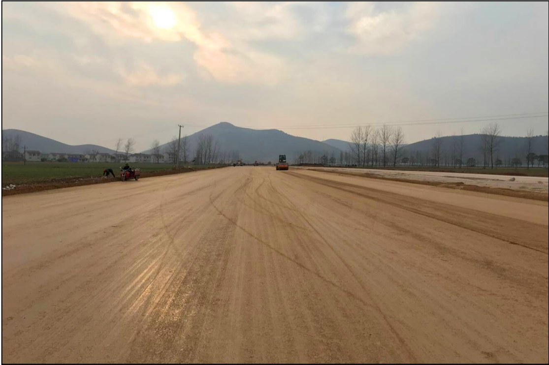
照片 1.4 路基碾压施工
